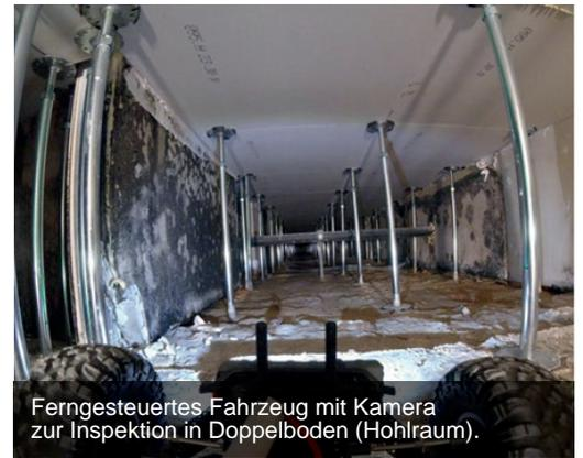
Ferngesteuertes Fahrzeug mit Kamera zur Inspektion in Doppelboden (Hohlraum).
