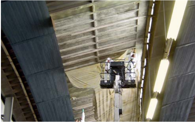
工場のコンクリート製天井のSRFによるすす除去
