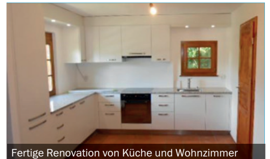
Fertige Renovation von Küche und Wohnzimmer
