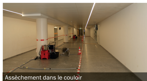
Assèchement de la dalle dans la salle de formation
