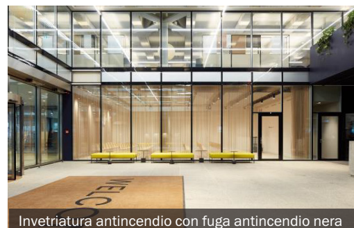
Invetriatura antincendio con fuga antincendio nera
